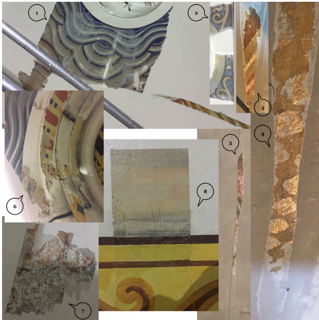
afb. 56 Fragmenten van de schilderijen in de kalot van de apsis, onder meer op de naden van de marouflage. 1) De wolk met de handen van God de Vader rond de oculus van het apsisgewelf. 2) Detail van de rand rond de oculus op de grens met de triomfboog. 3) Een stukje van de stralenkrans rond de wolk met de handen van God de Vader (1) op de naad van de marouflage. 4) Het pseudo-mozaïek van de achtergrond op de naad van de marouflage. 5) Fragment van de kleding op de naad van de marouflage. 6) Polychromie op de omlijsting van de oculus van het apsisgewelf. 7) Vermoedelijk de klauw van de leeuw van Marcus. 8) De grens te zien van de marouflage boven de sierrand. Herkomst bvhh.nu 2017; Davique.nl 2017. Collage bvhh.nu 2017.
