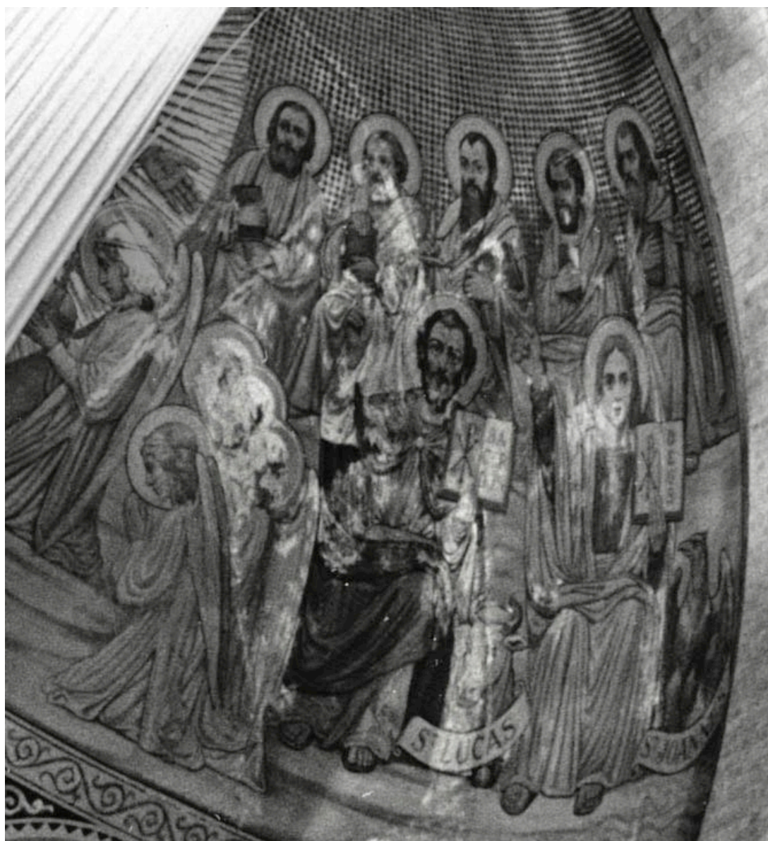
afb. 43 Geroteerd detail van een historische foto met het rechterdeel van de kalot. Heel duidelijk is de schade van salpeter. Foto F.H. van Dijk 1954. Herkomst Stadsarchief Rotterdam, nummer 4100_1976-14509.
