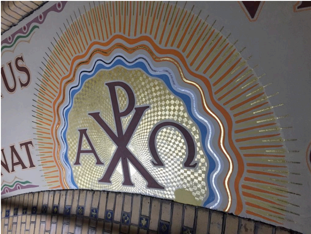
afb. 50 Het pseudo-mozaïek van het Christusmonogram in de top van de triomfboog is opgezet volgens de fibonaccireeks, bekend van het patroon van de zaden van de zonnebloem. Foto bvhh.nu 2017.
